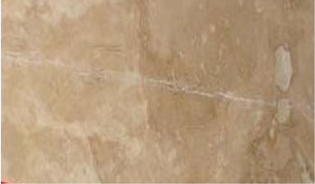
Şekil 3.14. Taş yüzeyinde oluşan çizikler
