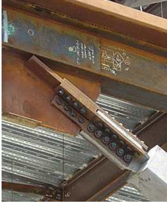
Şekil 2. 10 Standart Bulonlu Baęlantı
