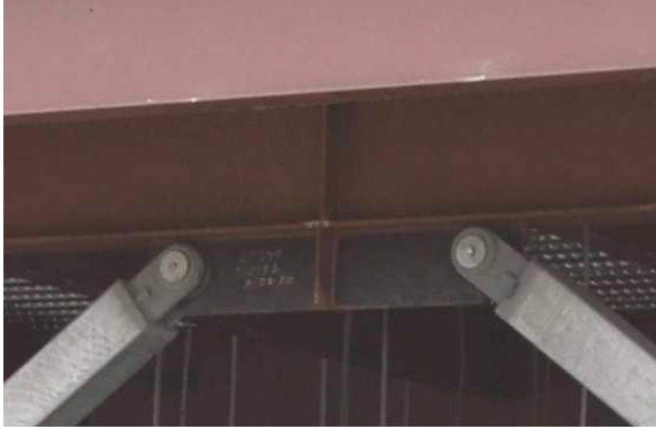
Şekil 2. 12 Pimli Bağlantılar
