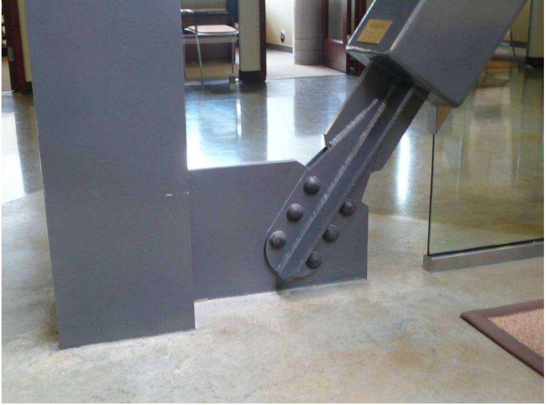
Şekil 2. 11 Geliştirilmiş Bulonlu Bağlantılar
