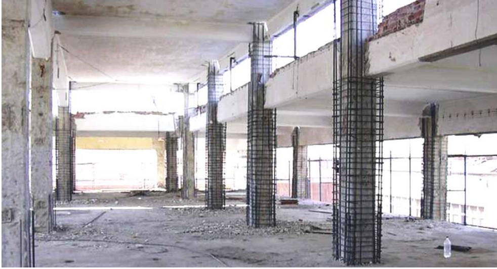
Ek 3. Şekil 1: Kolon mantolama uygulaması
