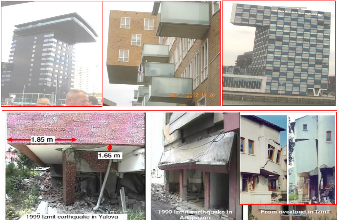
Şekil 2.6. Çıkmadan düzensizliğinden hasar gören yapı örnekleri
