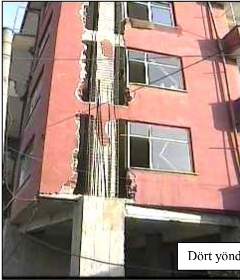
Şekil 4.4. Donatıların katlar arasında sürekliliğinin sağlanması
