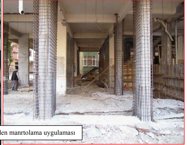
Şekil 4.4. Donatıların katlar arasında sürekliliğinin sağlanması
