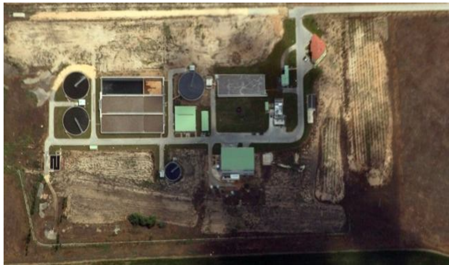
Şekil 9.1. EOSB Atıksu Arıtma Tesisinin genel görünümü
