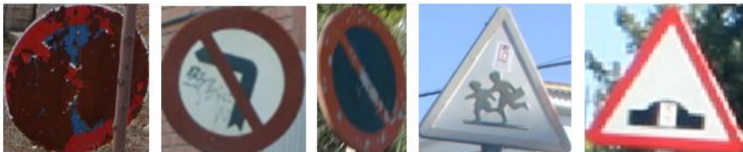
Şekil 2.9 Hasar görmüş trafik işaret levhaları
