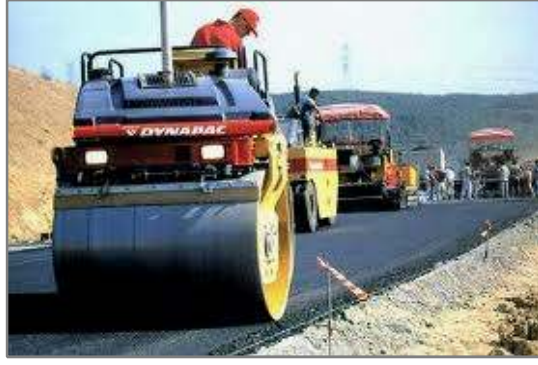
Şekil 2.5. Sıcak asfaltın yüzey düzeltme işlemi
