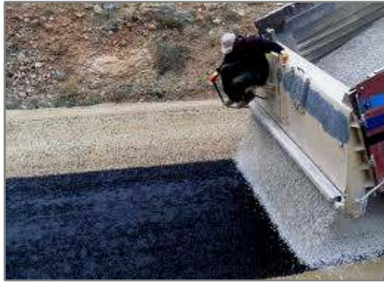
Şekil 2.3. Tek Tabaka Sathi Kaplama
