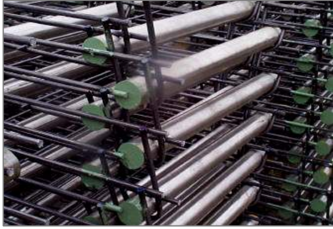
Şekil 3.7. JPCP ve JRCP kaplamalarda kullanılan ankraj donatısı
