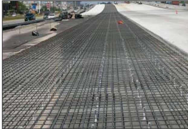
Şekil 3.13. Çin’de imal edilen CRCP tipi kaplamanın beton dökümüne hazır hali
