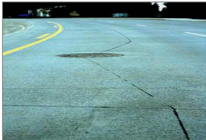
Şekil 3.11. Beton kaplamada derz kesimine örnek
