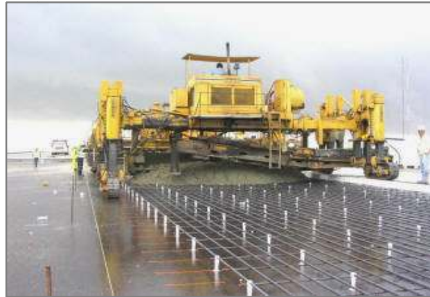
Şekil 3.19. Katı beton sericisi
