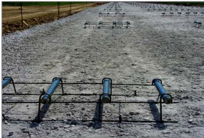
Şekil 3.8. Yol boyunca ankraj donatılarının serilmesi
