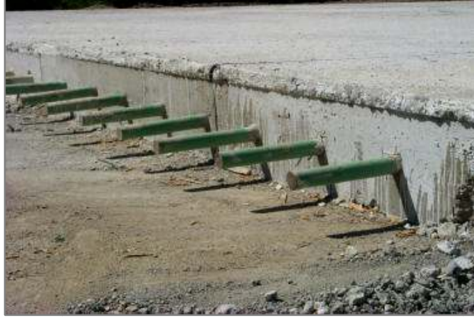
Şekil 3.9. Ankraj donatısının beton dökümünden sonraki hali
