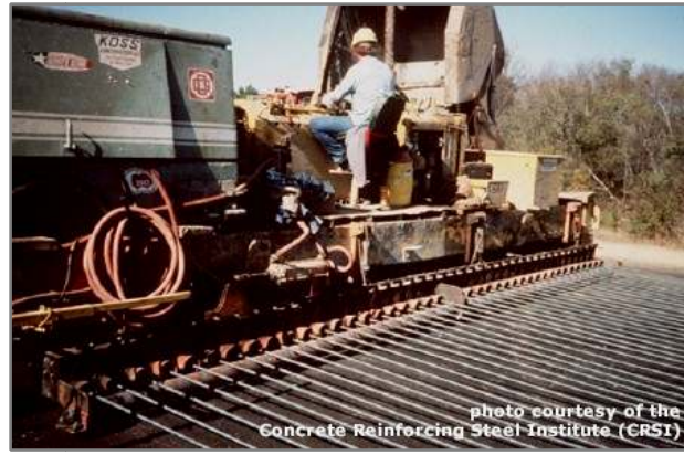
Şekil 3.18. Makine ile çelik serimi
