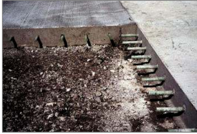
Şekil 3.10. Beton Dökümünü bekleyen son durum
