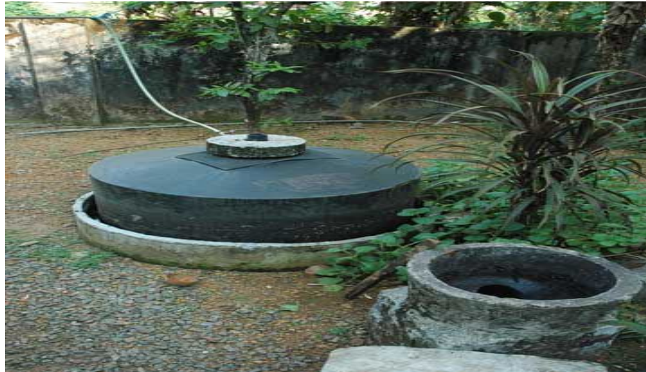
Şekil 3.16. İlkel Yöntemle İşletilen Biyogaz Sistemi (Güç, 2010)
