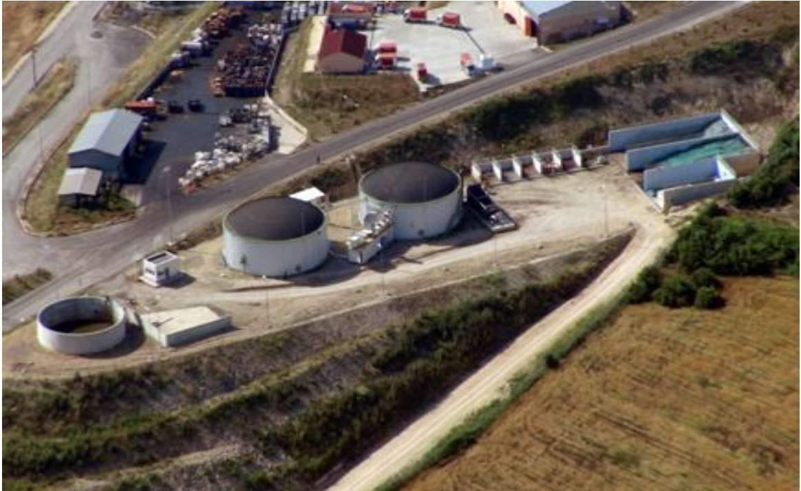
Şekil 3.21. Kocaeli İzaydaş Biyogaz Üretim Tesisi ( http://biyogaz.mam.gov.tr/ )
