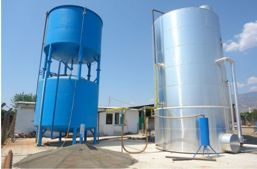
Şekil 3.20. Aydın’ın Pamukören Beldesi’nde İşletilen 50 m 3 Kapasiteli Biyogaz Sistemi (Güç, 2010)
