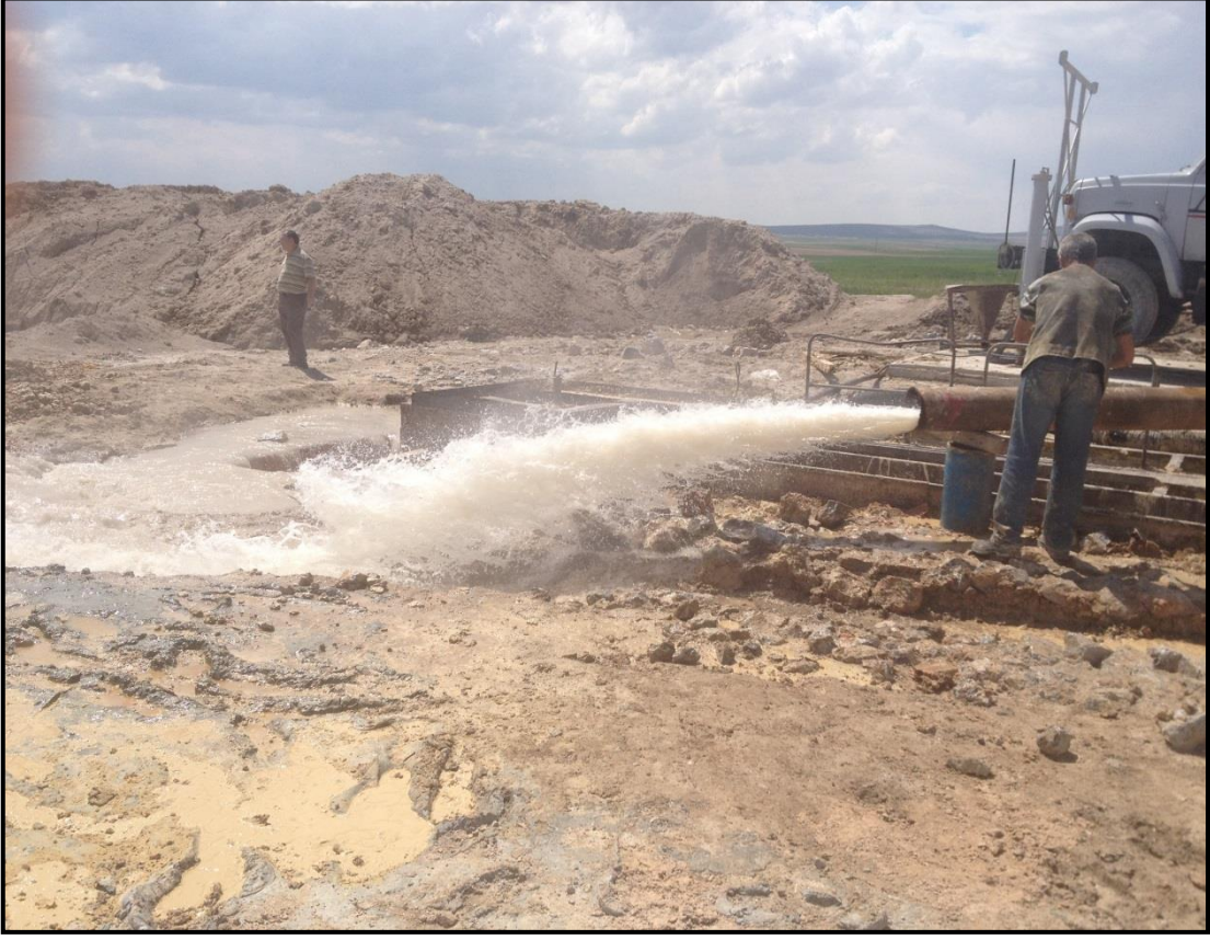
Şekil 5.30. EMİ-2012/4 kuyusunda kompresörle yapılan yatay üretimden bir görünüm.
