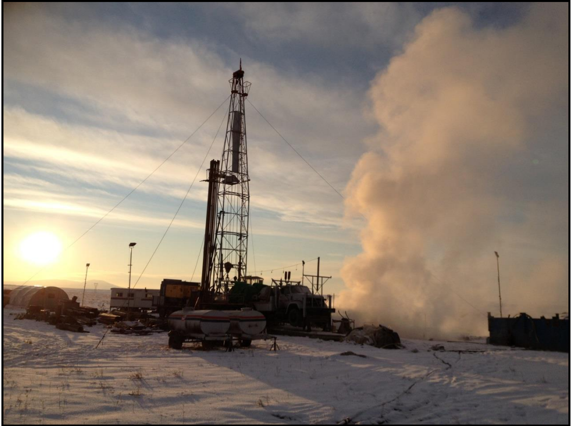
Şekil 5.26. EMŞ-2011/24 kuyusunda kompresörle yapılan yatay üretimden bir görünüm.
