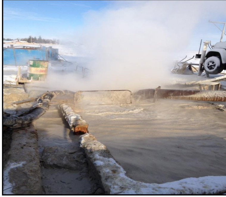
Şekil 5.25. EMŞ-2011/24 kuyusunda kompresörle yapılan ilk yatay üretimden bir görünüm.
