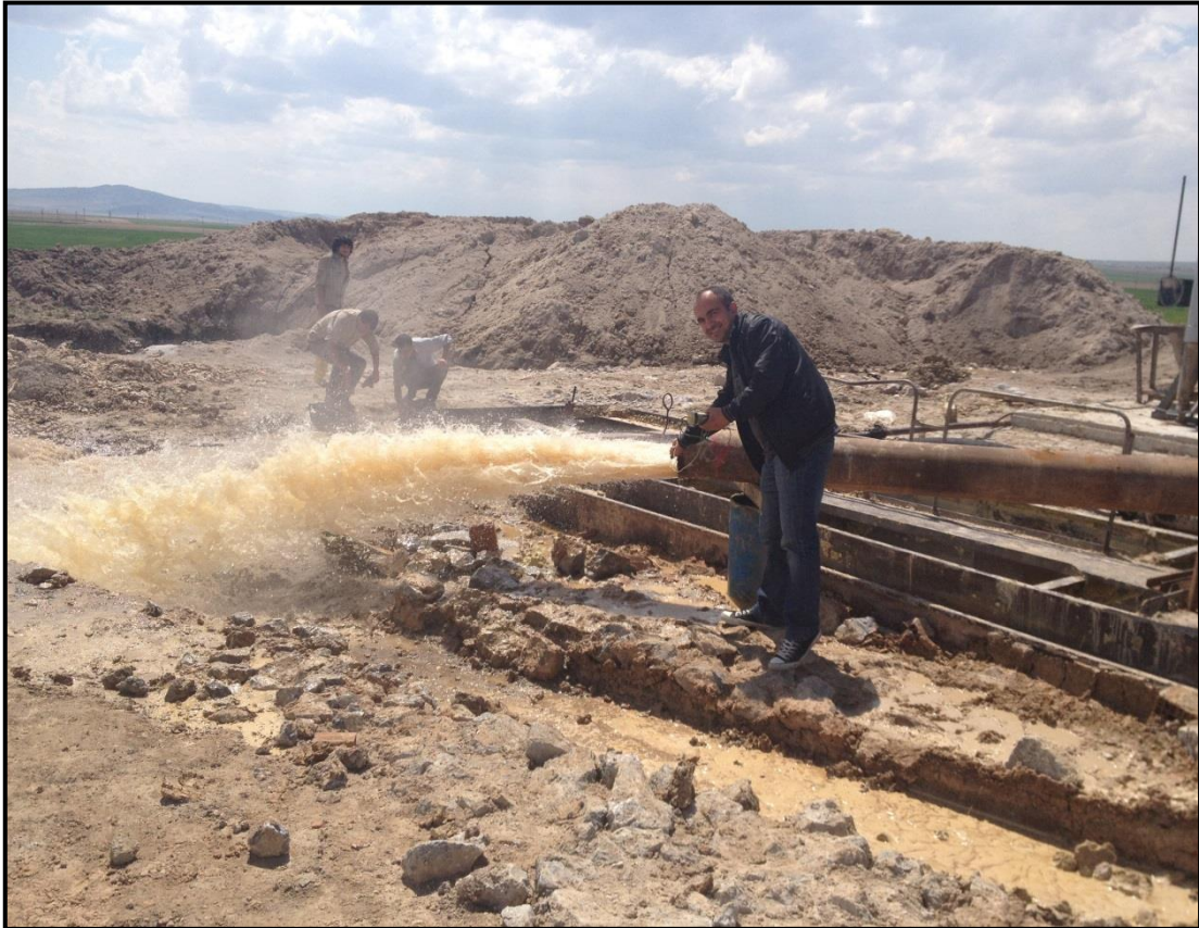
Şekil 5.29. EMİ-2012/4 kuyusunda kompresörle yapılan ilk yatay üretimden bir görünüm.
