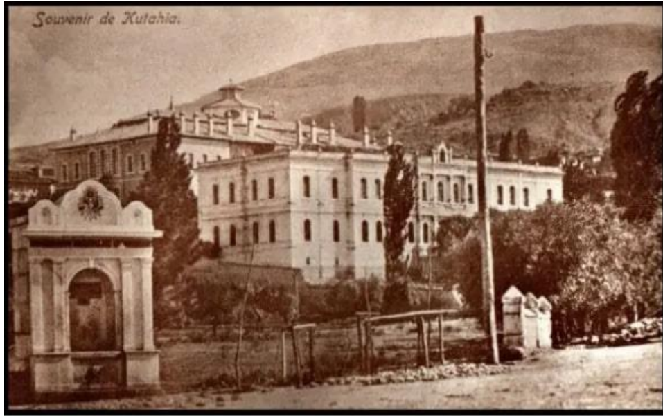
Şekil 4.70. Hürriyet Çeşmesi, Kütahya İdadisi ve Hükümet Konağı, 1907 (Verim, 2019; Keykubatlı, 2020).
