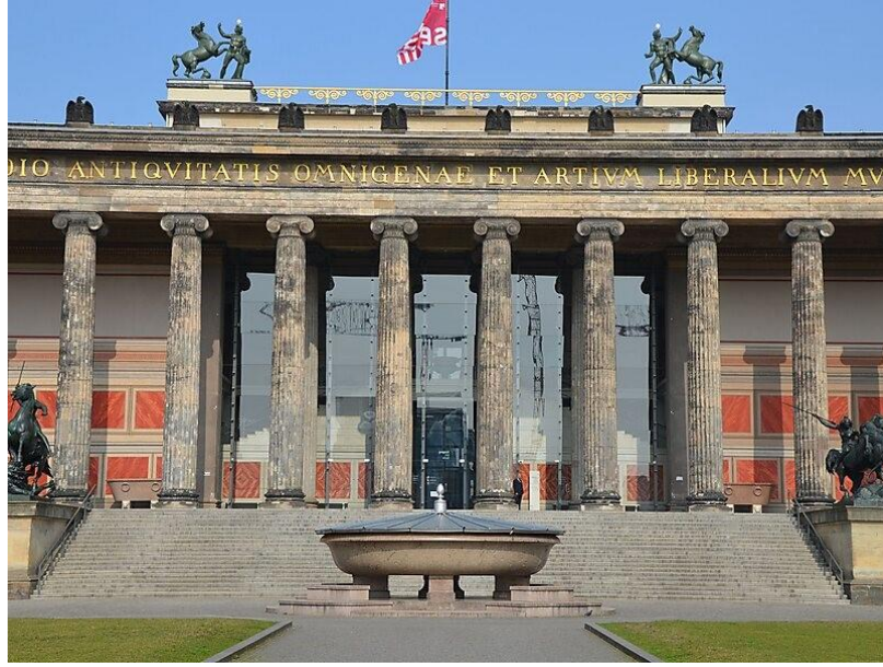
Şekil 4.7. Merdivenlerle yükseltilen bina oturma alanı, Altes Müzesi, Almanya (İpek, 2009).
