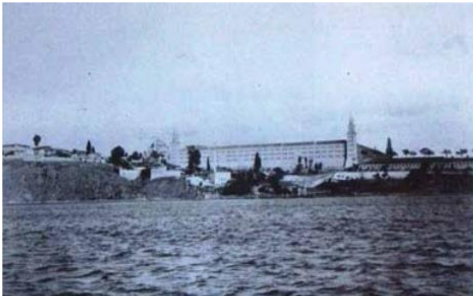
Şekil 4.14. Selimiye Kışlası'nın silüeti (Tuğlacı, 1993; Alioğlu, 2012).
