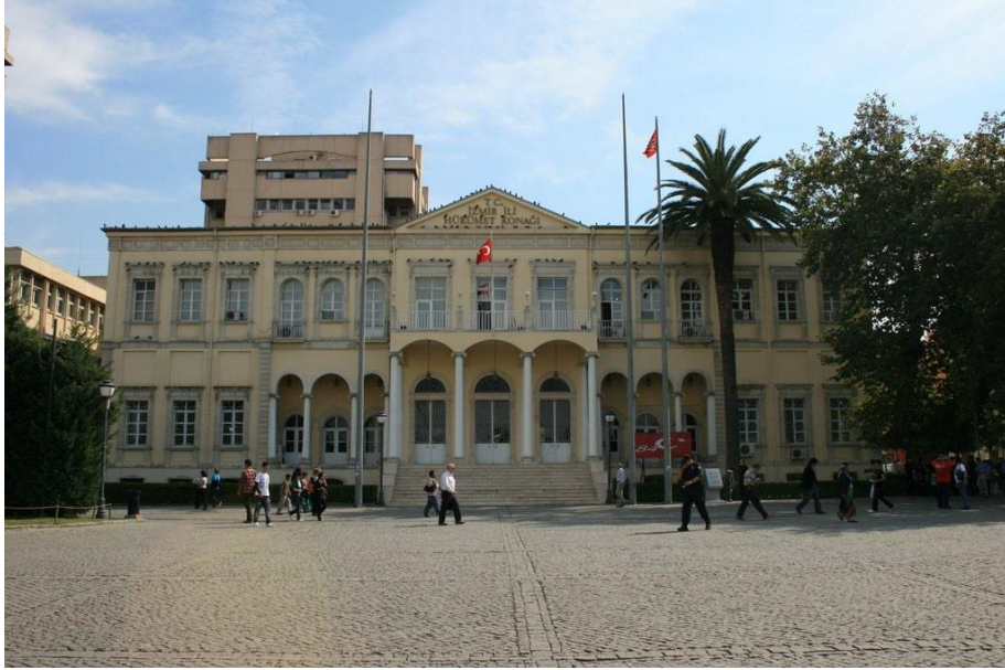
Şekil 4.53. İzmir Hükûmet Konağı yenide yapılan binanın ön görünüşü (T.C. Kültür Turizm Bakanlığı, 2020).
