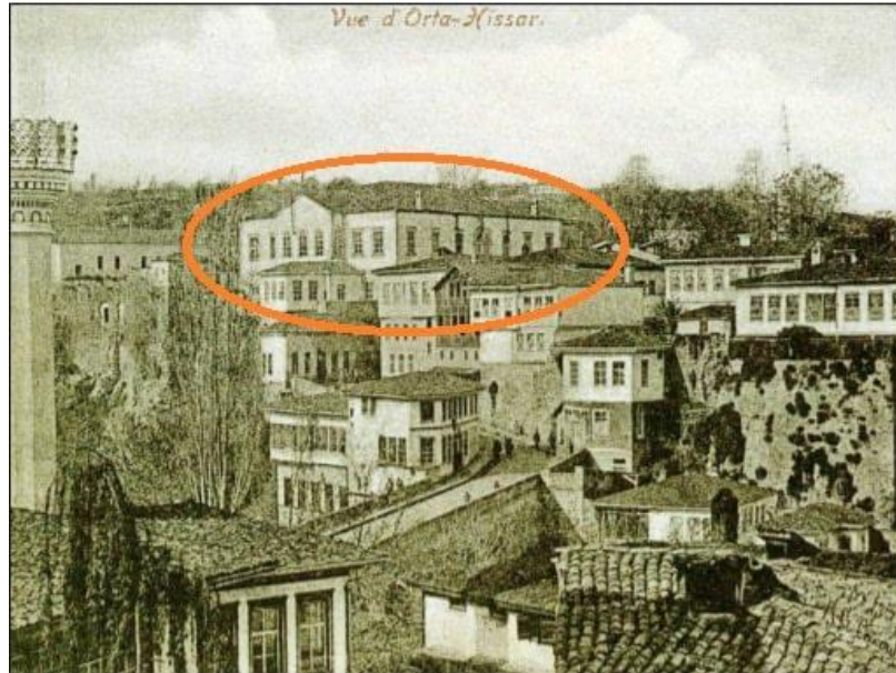
Şekil 4.35. Trabzon Hükûmet Konağı'nın şehir silüeti üzerindeki görüntüsü (Bölükbaşı, 2006; Yazıcı, 2008).
