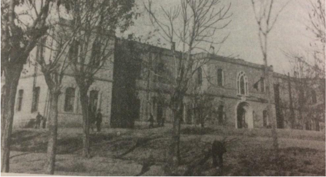
Şekil 4.59. Ankara Hükûmet Konağı ön görünüşü (Avcı, 2016).
