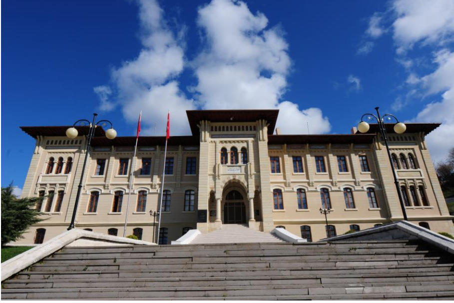
Şekil 4.64. Kastamonu Hükümet Konağı ön cephesinden bir görünüş (T.C. Kastamonu Valiliği, 2020).
