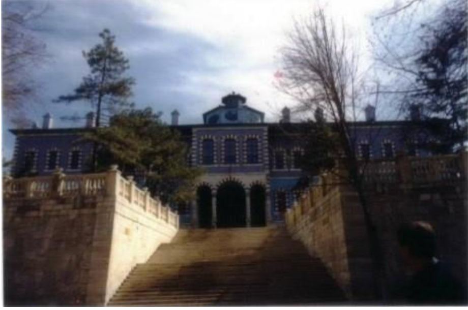
Şekil 4.75. Kütahya Eski Hükûmet Konağı Neoklasik mimari etkileri (T.C. Kültür Bakanlığı Eskişehir Kültür ve Tabiat Varlıklarını Koruma Müdürlüğü, 2000).
