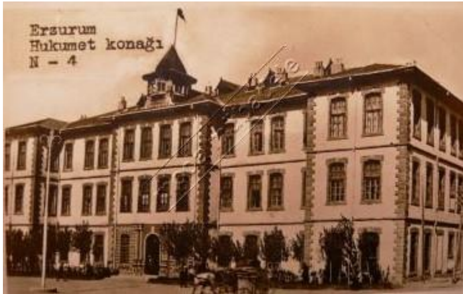
Şekil 4.68. Erzurum Hükûmet Konağı ön görünüşü (Moda Müzayede, 2020).
