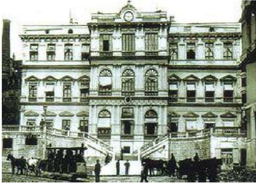
Şekil 4.22. Altıncı Daire-i Belediye ön görünüşü (Akın, 2011).
