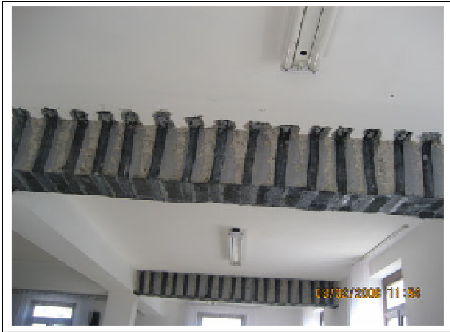
Şekil 5.14 Lifli polimer uygulaması örneği.
