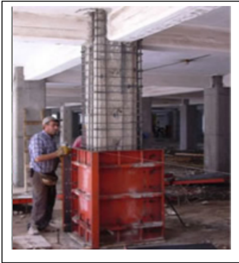
Şekil 5.6 Kolon mantolama örnekleri (Doğan, ???).
