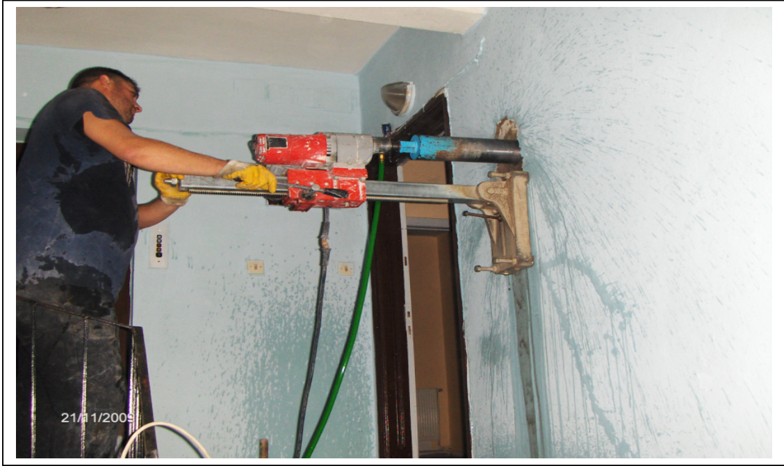
Şekil 2.10. Binadan karot alınması.
