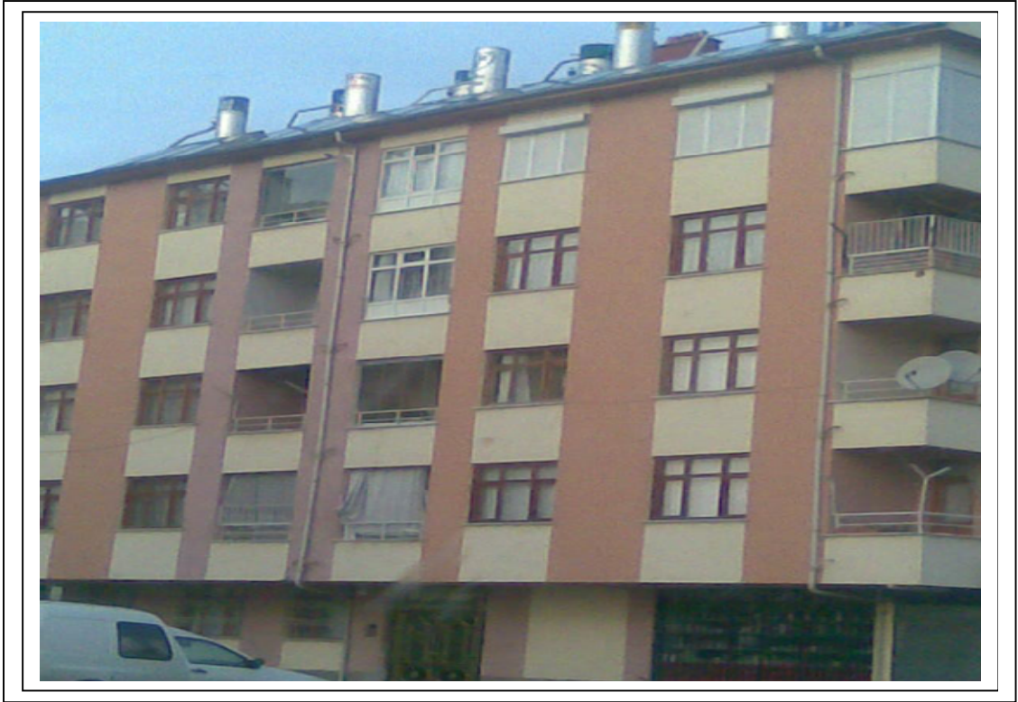
Şekil 2.1 S.S. Üçpınarlar Yapı Kooperatifi A blok fotoğraf.
