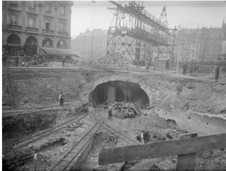
Şekil 3.11 Paris metrosu tünel inşaatı (1902-1910) [11]
