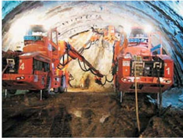
Şekil 3.1 Jumbo aygıtıyla patlayıcıların yerleştirileceği lağım deliklerinin açılması [8]
