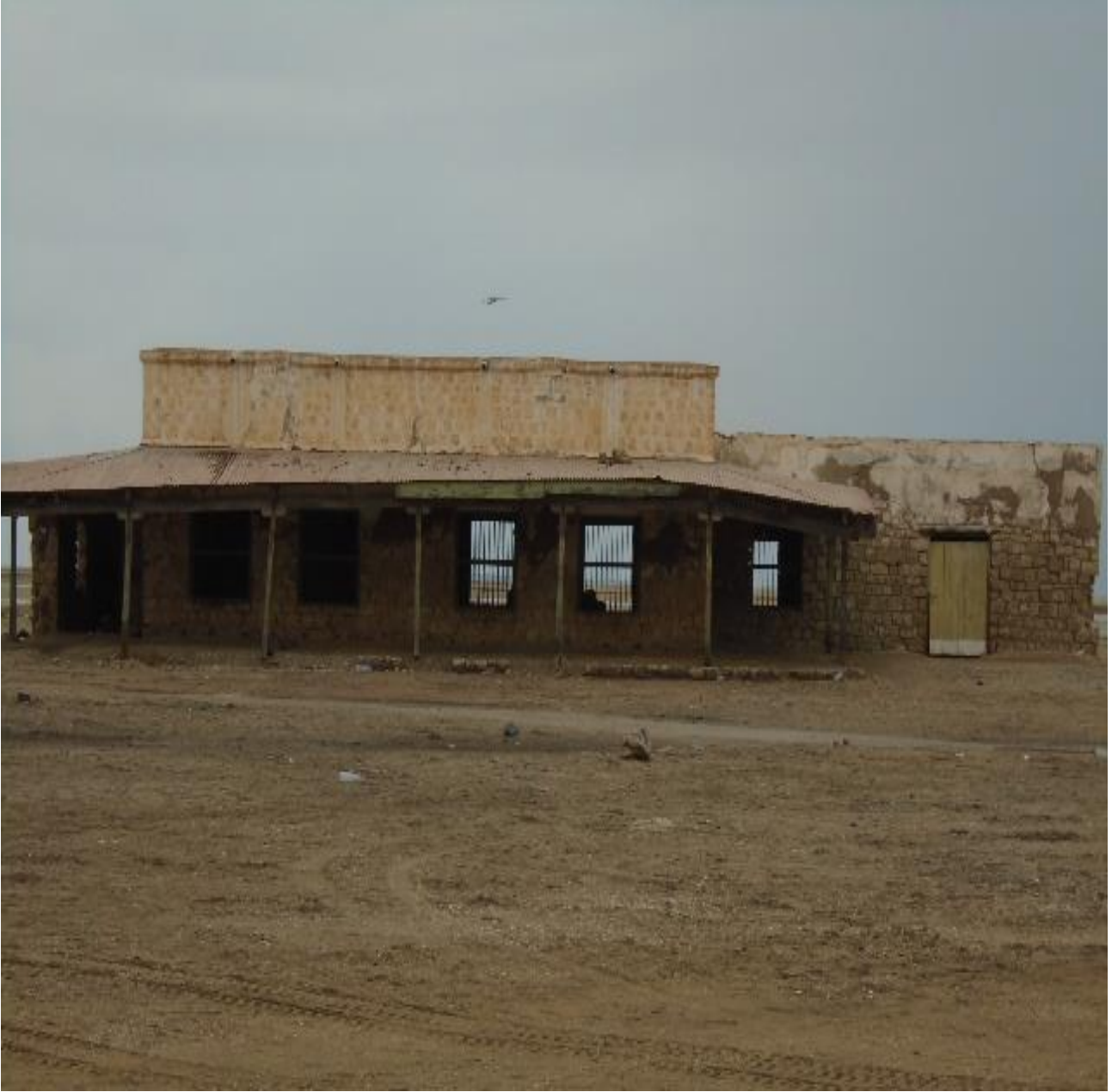
EK 16: Zeyla'da Eski Gmrk Binası
