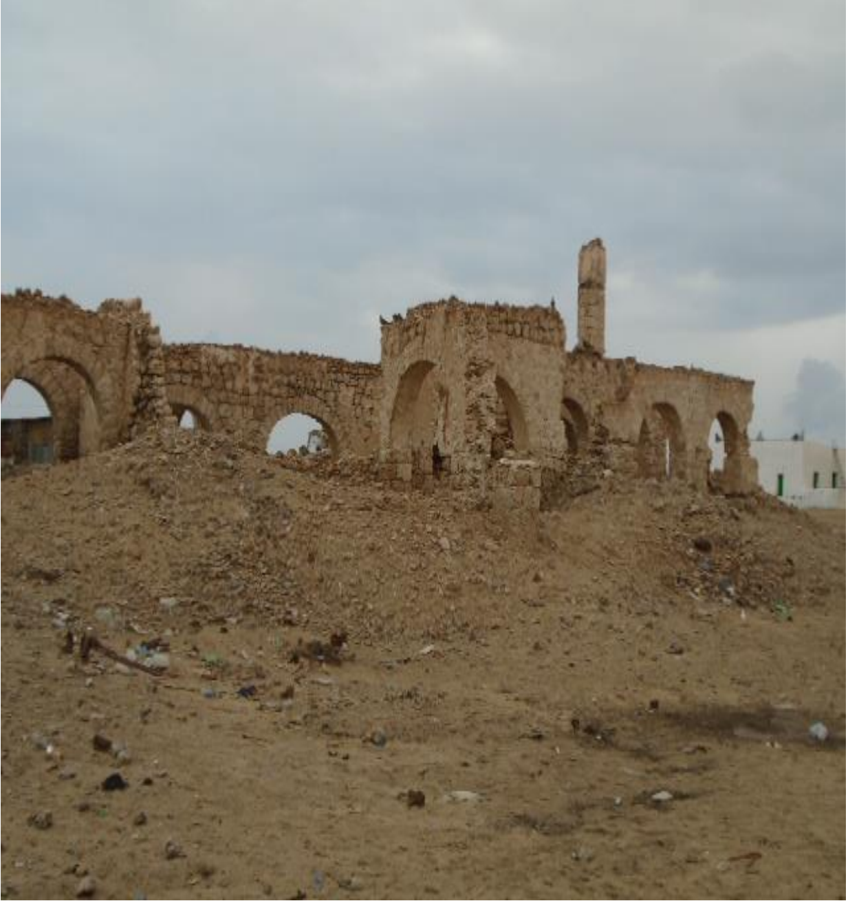
EK 13: Zeyla'da Eski Mahkeme Binası
