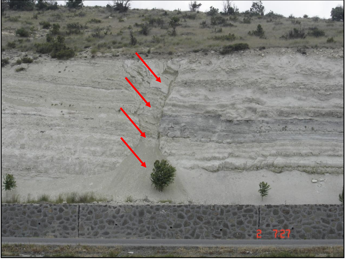
Şekil 3.15. Kırmızı oklar Kütahya Eskişehir karayolu 65. km yol yarmasında Miyosen yaşlı kaya birimleri içerisinde gelişmiş fayı işaret etmektedir. Bakış yönü doğuya doğrudur. (WGS 84 sisteminde GPS Koordinatları:36 245121 D, 43 75370 K)
