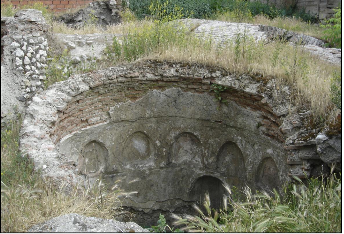
Şekil 4.6. Kütahya şehir merkezinde bulunan ve geçmişte hamam olarak kullanıldığı düşünülen gömülü tarihi yapı
