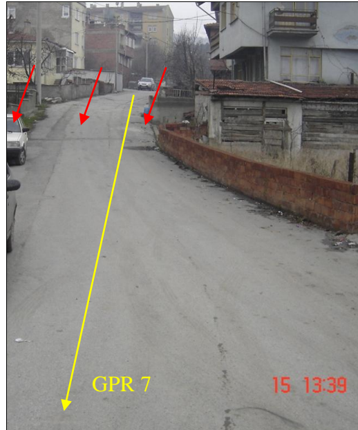
Şekil 3.38. Kütahya şehir merkezinin yaklaşık 2 km kuzeybatısında GPR 7 profilinin alındığı lokasyon. Bakış yönü kuzeye doğrudur. Kırmızı oklar fayın muhtemel yerini ve morfolojik sarplığı, sarı çizgi ve ok GPR profillerinin alındığı yerleri ve oklar gidiş yönünü göstermektedir.
