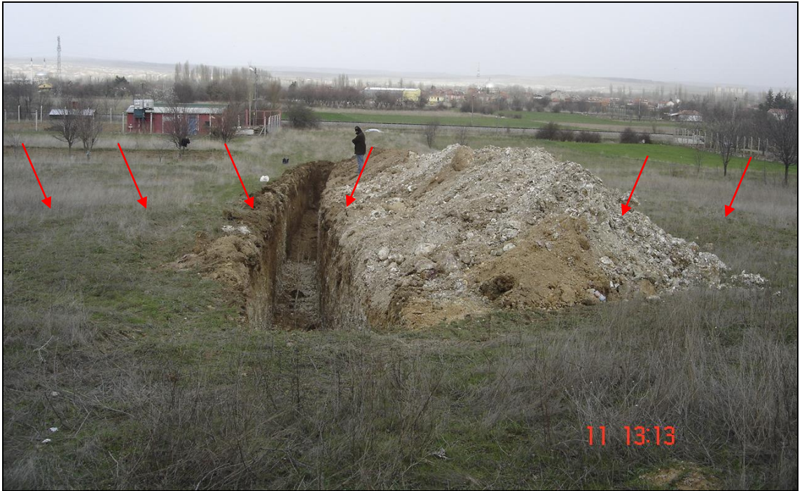
Şekil 3. 48. Okçu hendeği genel görünümü. Kırmızı oklar morfolojik sarpılığı ve hendeğin içerisinde fayın gözlemlendiği kesimi işaret etmektedir. Bakış yönü kuzeye doğrudur.
