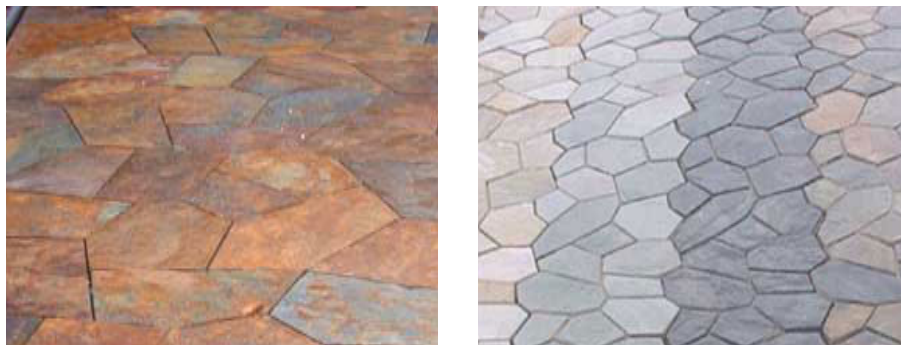
Şekil 3.11. Yer döşemesi olarak uygulanmış ebatlı kayrak taşı
