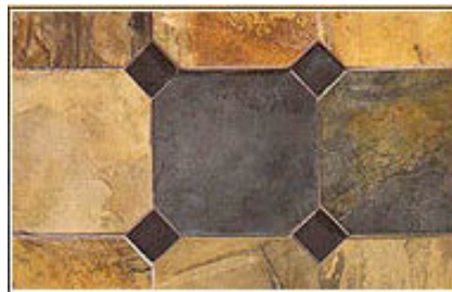
Şekil 3.14. Ebatlandırılmış kayrak taşlarından yapılmış bir döşeme tasarımı
