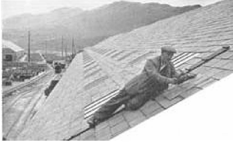
Şekil 3.7. İngiltere’de 1900’lü yılların başlarında kayrak taşlarının çatı kaplama malzemesi olarak kullanılmasını gösteren bir şekil
