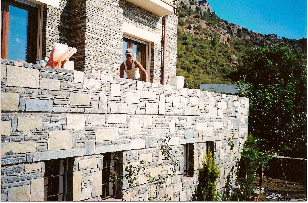
Şekil 3.12. Bina duvarlarına duvar kaplaması olarak uygulanmış ebatlı kayrak taşı
