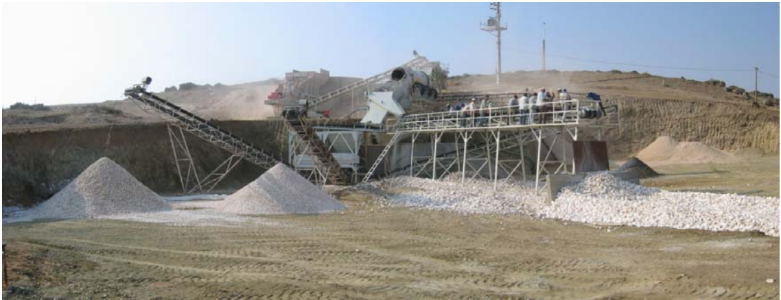
Şekil 5.41. Kırma, yıkama ve ayıklama tesisi genel görünüşü
