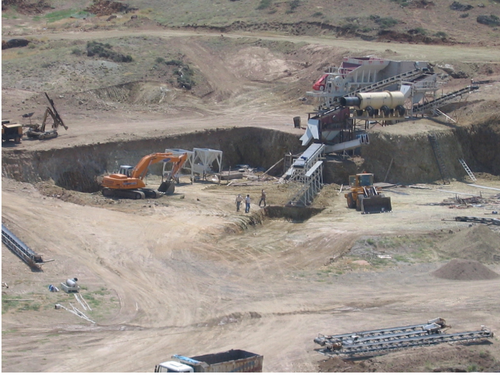
Şekil 5.40. Kırma, yıkama ve ayıklama tesisinin kurulum aşaması
