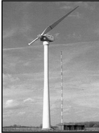
Şekil 4.9. Tek kanatlı rüzgar türbini (Gelberi vd., 2003).
