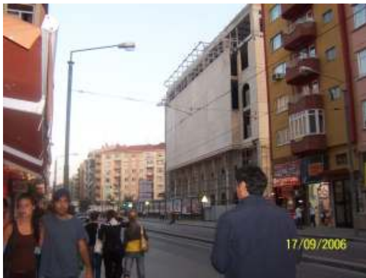
Şekil 3.30., Kanatlı Alışveriş Merkezi şantiye alanından, Eylül /Ekim 2006'da çekilmiş fotoğraflar
