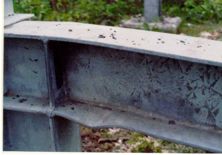
Şekil 1-3 Flanş Lokal Burkulması
