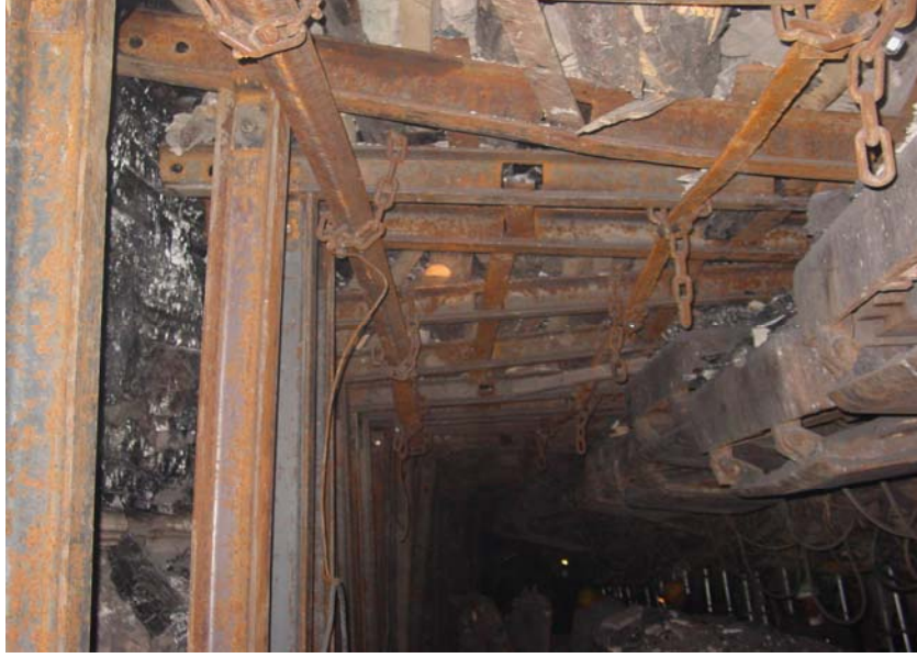
Şekil 4.1.a Söküm havesinin birinci bölümünün açılması sonunda ayağın görünümü
