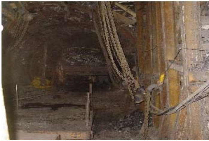
Ek B.9 Tahkimatın yükleme platformunda triko üzerine çekilmesi
