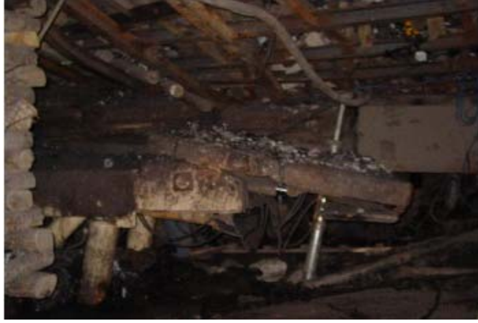
Ek B.8 Tahkimatın söküm havesinden galeriye çıkarılması
