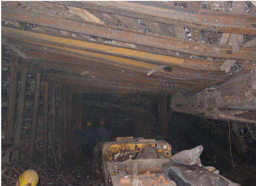
Şekil 4.3.a Söküm havesi ikinci bölümünün hazırlanmasından bir görünüm
