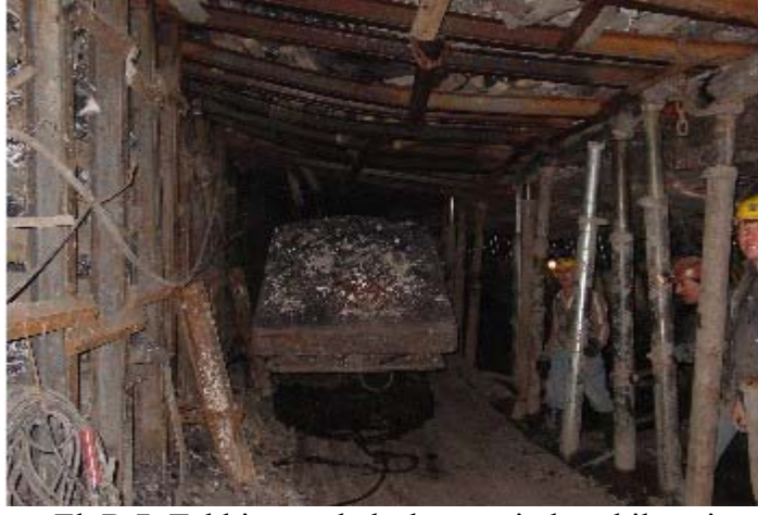
Ek B.7 Tahkimatın kalaslar üzerinde çekilmesi
