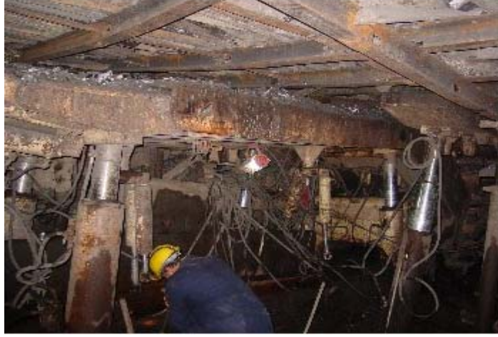
Ek B.4 Anayol tahkimatının demontajı
