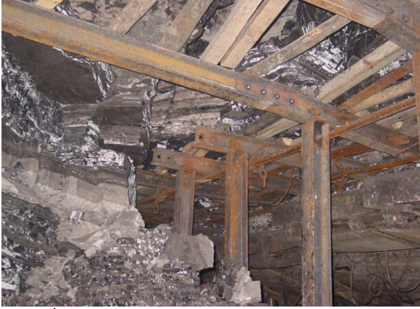
Şekil 4.2 İkinci bölümün açılması sırasında yeni boyunduruğun birinci bölümdeki boyunduruğa bağlanması
