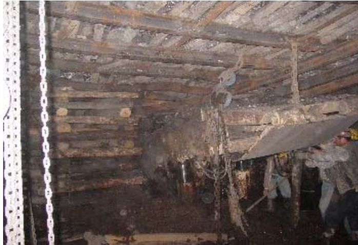
Ek B.6 Tahkimatların söküm havesine çekilmesi
