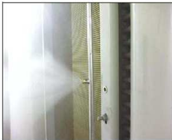
Şekil 3.13 Sisleme sistemli ıslak-kuru soğutucu (Acül, 2007)
