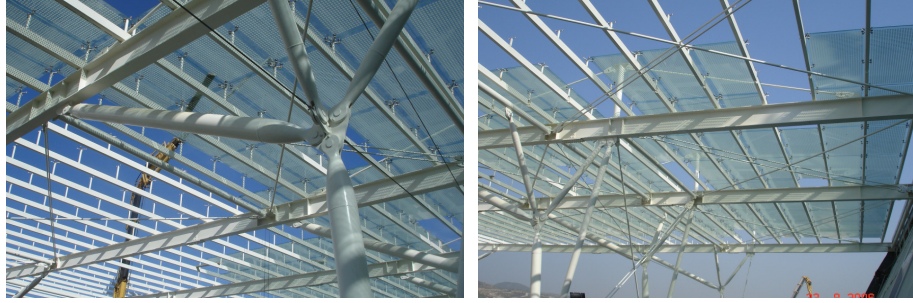
Şekil 4.1.15 Kanopi Üstü Cam Detayları
