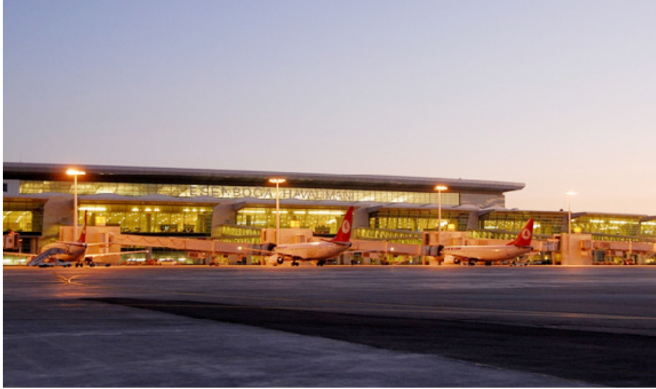
Şekil 4.2.1 Ankara Esenboğa Yeni İç-Dış Hatlar Havalimanı Apron Görünüşü
