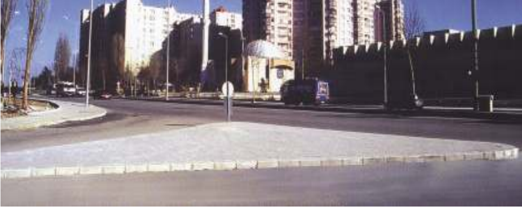
Şekil 5.19. İnönü Bulvarı Tretuvar ve Bordür Çalışmaları
