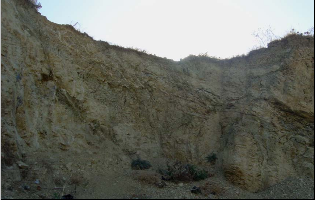
Şekil 3.27. Antakya şehir merkezinin yaklaşık 5 km kuzeydoğusunda K70^0D uzanımlı ve yaklaşık 50^0 KB 'ya eğimli faylar temel kayaç olarak adlandırılan kireçtaşları ile kil-marn-kireçtaşı ardalanmasının sınırını oluşturmaktadır. Ayrıca kil-marn-kireçtaşı ardalanması içerisinde bu fayların antitetiği olan faylarda gözlenebilmektedir (fotoğraf kuzeyden güneye çekilmiştir ve yarmanın yüksekliği yaklaşık olarak tabandan 2 m'dir).
