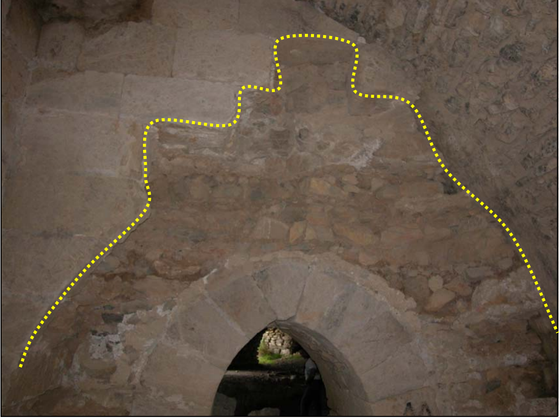
Şekil 6.24. Bakras Kalesi'nin bazı kesimlerinde, kalede tadilat yapıldığını ortaya koyan, sonradan yamanmış duvarlar göze çarpmaktadır (sarı çizgiler farklı tür taşlar kullanılarak yenilenmiş kesimleri göstermektedir).
