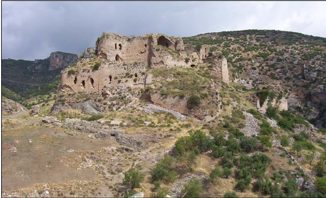
Şekil 6.20. Bakras Kalesi genel görünümü (bakış yönü doğudan batıya doğrudur).
