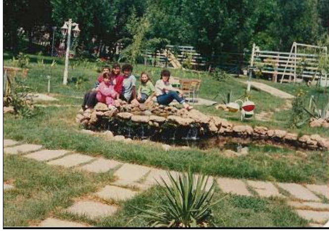
Şekil 3.18 Şeker Lojmanlarında yeşil doku içerisinde sosyal biraradalık, 1980 (P. Çingir'den, 2009).
