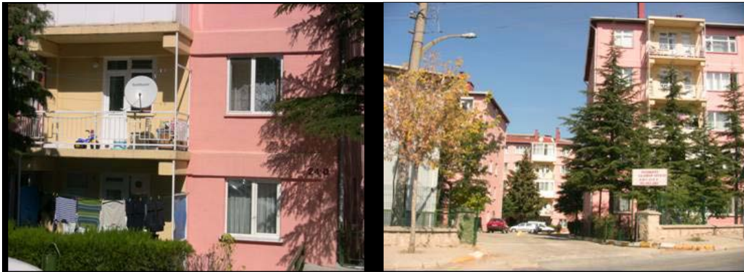
Şekil 3.35 İlk grup yapılardan cephe görünümü, 2009.
