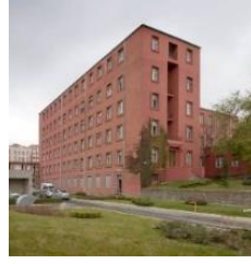
Eski Ticaret Bakanlığı (1934–35) Mimar: Clemens Holzmeister
