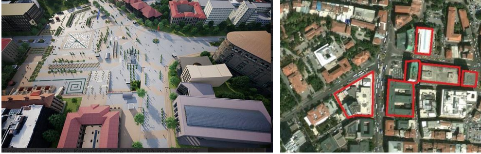
Şekil 5.26. Ulus Tarihi Kent Merkezi Yenileme Alanı Projesi ve yıkılacak yapılar, (Arkitera, 2020).
