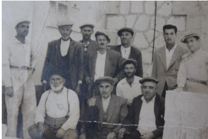
Görsel 33: Esentepe Mahallesi ilk muhtarı Mehmet Emin Bozkurt ( en ön sırada sağ baştan ilk) ve mahalleli Esentepe Mahallesi Ulu Camii inşaatında, 1968, Kubilay Bozkurt aile albümü, Eskişehir
