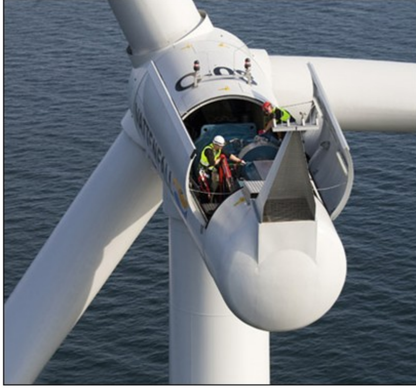
Şekil 2.8. Büyük rüzgâr türbinlerinde gövde bakımı ( http://www.siemens.com/press/en/presspicture/?press=/en/presspicture/2009/renewable_energy/ere20080806-02.htm , 2011).
