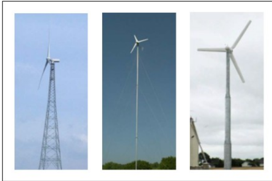
Şekil 3.5. Yatay eksenli rüzgâr türbinlerinde kullanılan kule tipleri, ( http://www.centralwestsolar.com.au , 2011).
