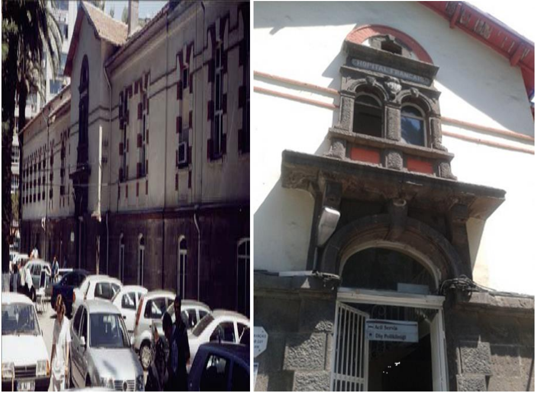
Resim 15: Fransız Hastanesi A Blok'un Dış Görünümü (solda) Fransız Hastanesi A Blok'un Ana Girişi (sağda) 293
