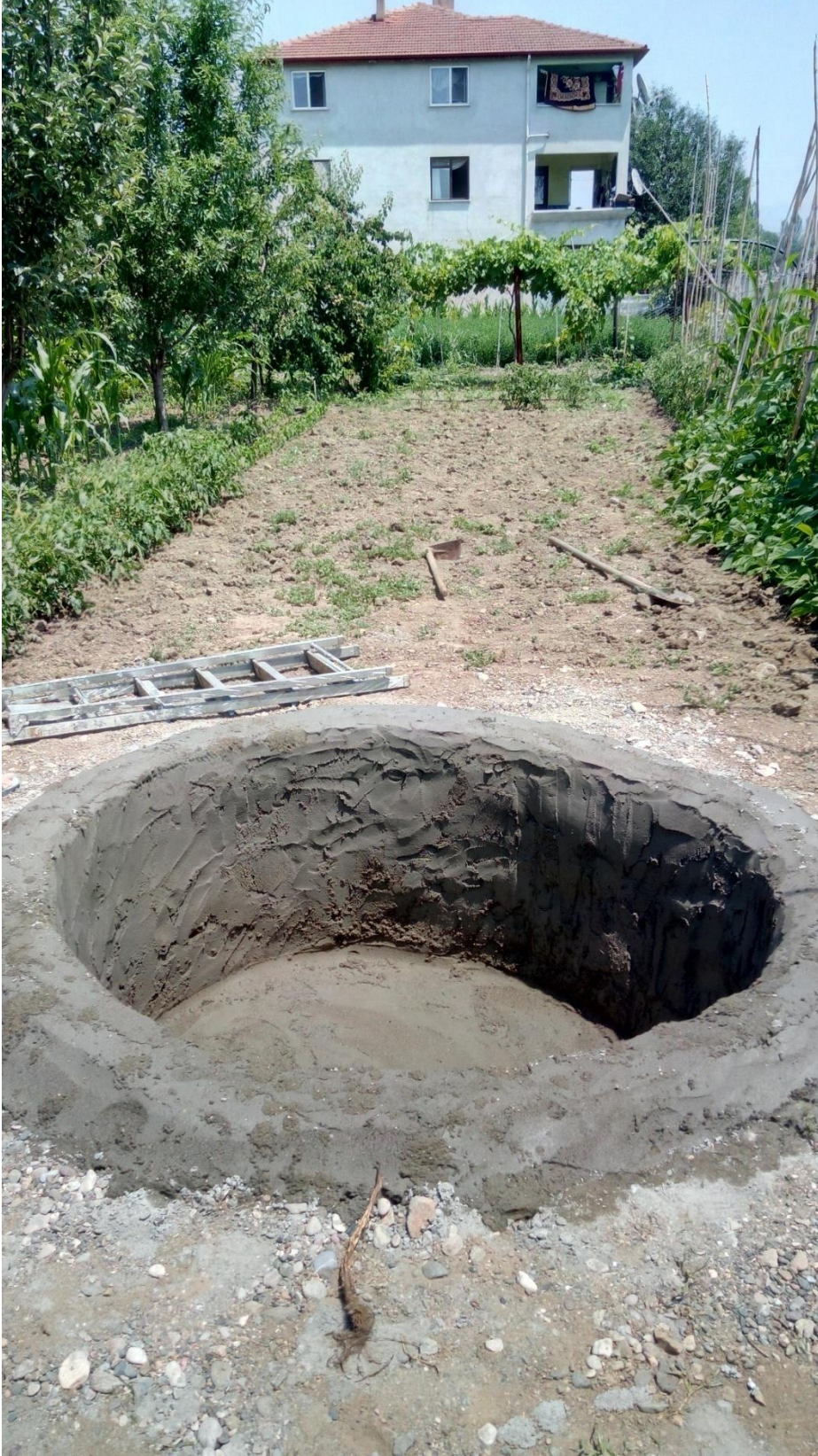
Şekil 3.4. Akuakültür havuzunun hazırlanması. (d)
