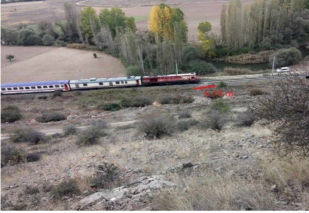
Şekil 5.16. Kaya düşmesi gerçekleşen yamaçtan demiryolu görünümü.
