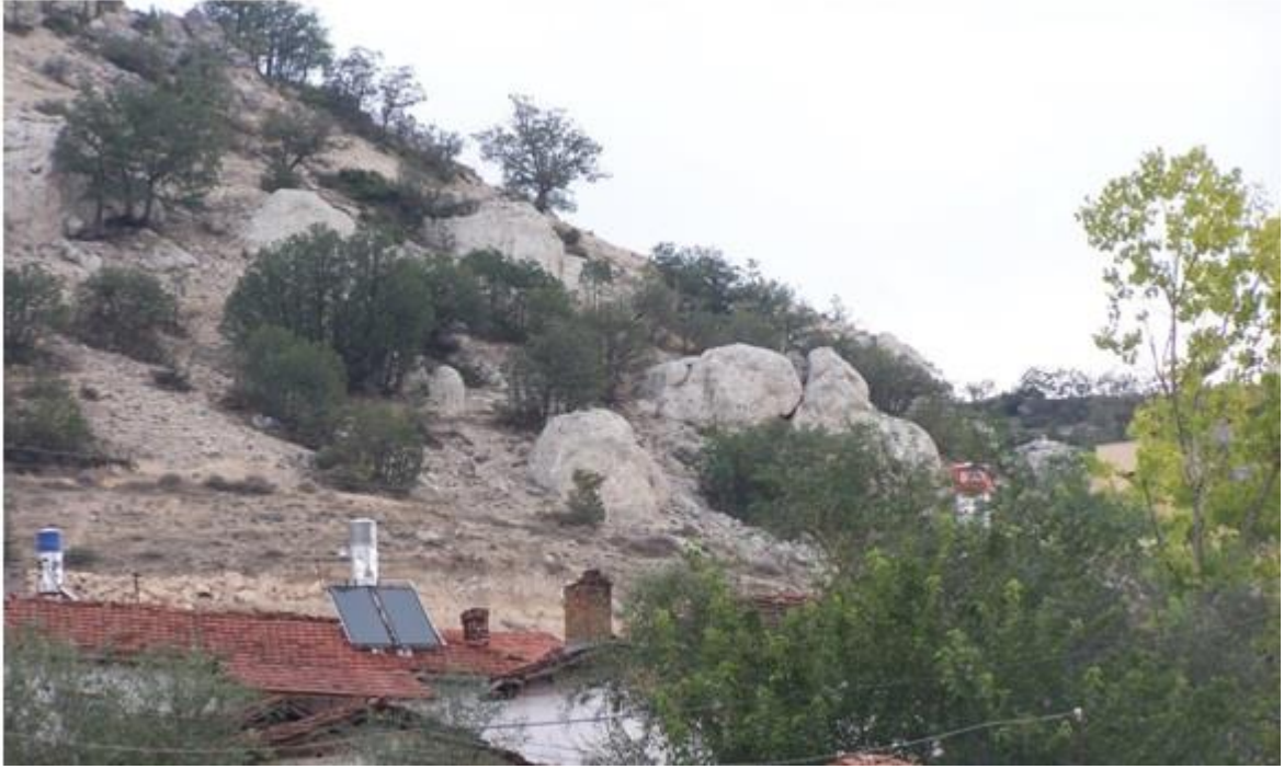
Şekil 2.4. İncelemeler sırasında Yörük kırka köyünün kurulduğu yamaç üzerinde görülen ve askıda bulunan serbest kaya blokları.
