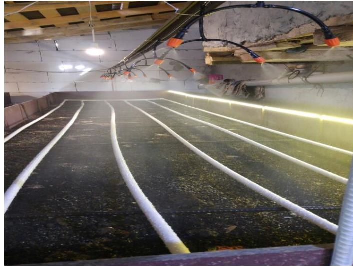
Şekil 3.5. Isıtma sisteminin kurulumu (Fotoğraf: Osman ŞEN)
