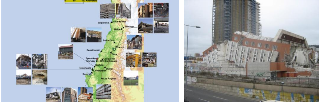
Şekil 4.17. Şili depremi sonrası etkilenen bölgelerdeki hasarlar (RMS, 2011) (Cowan, 2011)
