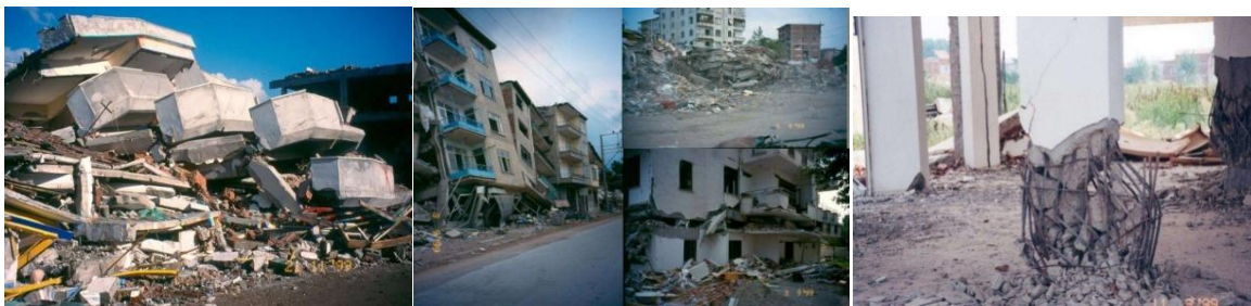
Şekil 4.29. Deprem sonrası konutların durumu (Akıncıtürk, 2012)
