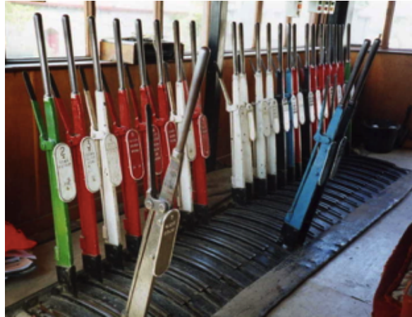
Şekil 2.18: Mekanik Anlaşıman ( Principles of Railway interlocking )
