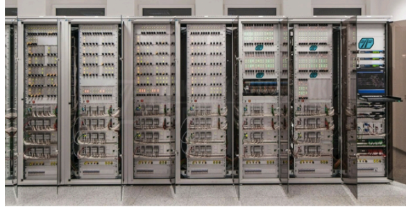
Şekil 2.21: Elektronik Anlaşman ( Computer-based interlocking system MOR-3 )
