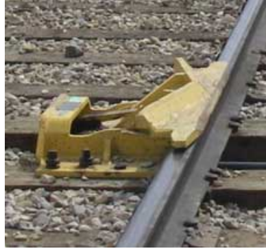
Şekil 2.9: Derayman ( Derail Device )
