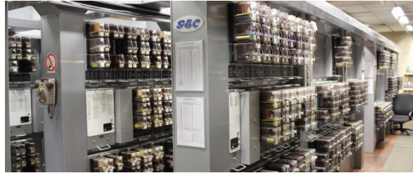
Şekil 2.20: Röleli Anlaşman ( Evolution of Signalling Control )
