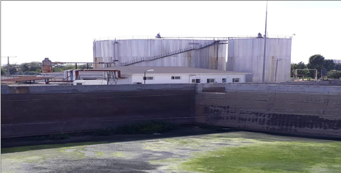
Şekil 3.3. Ankara şeker fabrikası dengeleme havuzu
