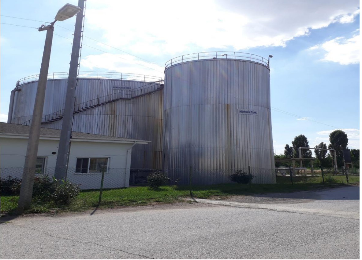
Şekil 3.4. Ankara şeker fabrikası hidroliz ve anaerobik tank
