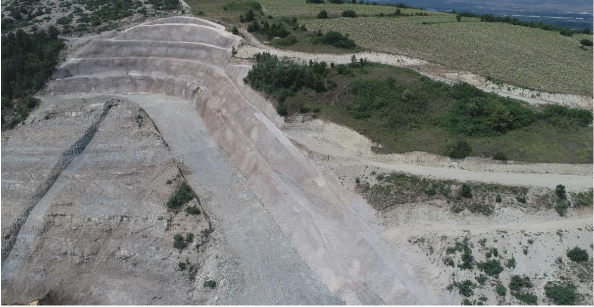
Şekil 4.1. Hocaköy Barajı Aks Yeri Sol Sahil Şevi (Mansaptan Bakış) (DSİ, 2018)
