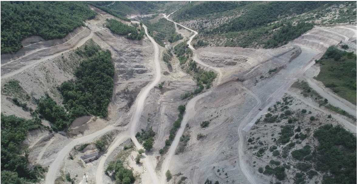
Şekil 4.2. Hocaköy Barajı Aks Yeri Sağ ve Sol Sahil Şevleri (Mansaptan Bakış) (DSİ, 2018)
