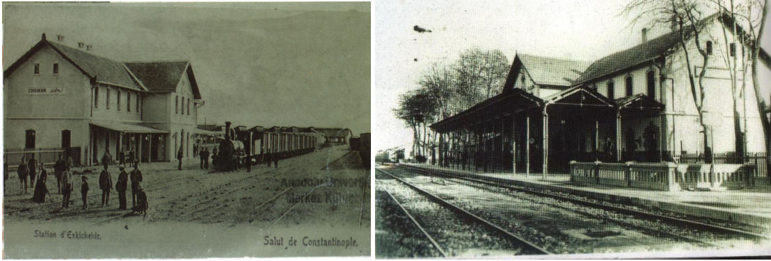
Şekil 3.24., 1900-1920, Eskişehir'in birinci ve ikinci gar binası (Kılıç,L.,1997)
