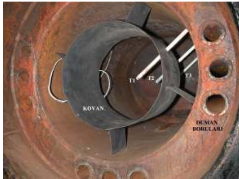
Şekil 5.15. Kovan adı verilen dolgu maddesinin ocak içine yerleştirilmesi.
