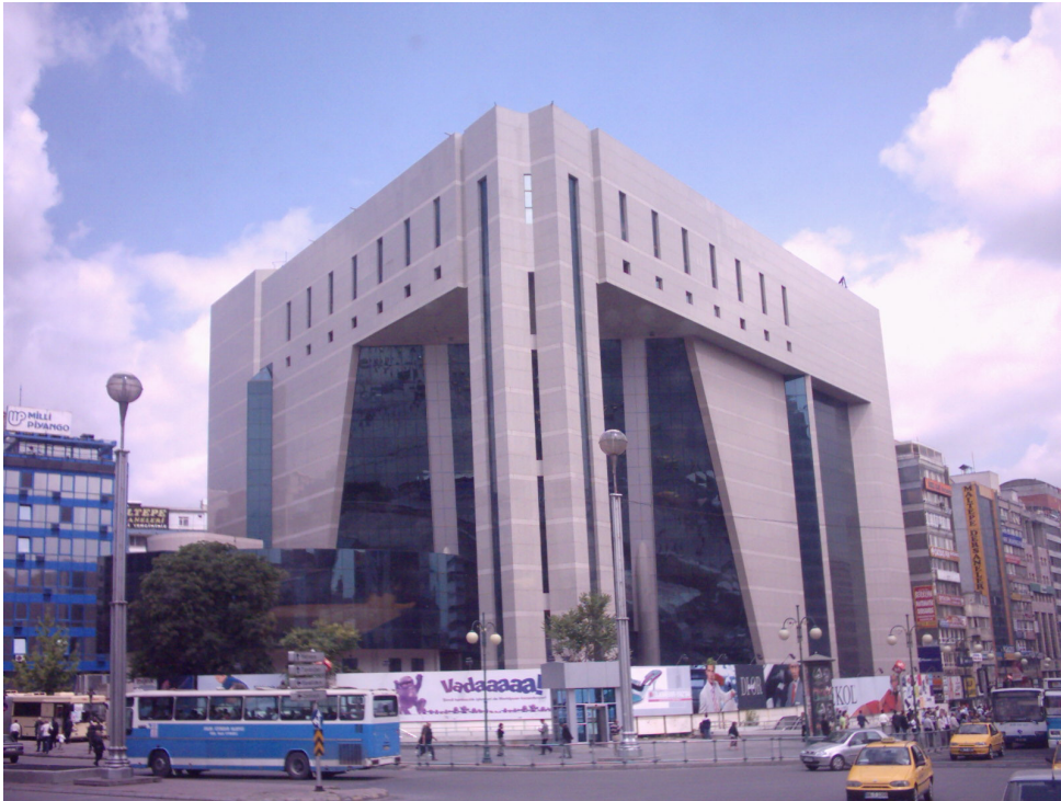
Şekil 4.5 Kızılay Binasının Bugünkü Hali
