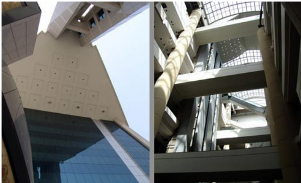
Şekil 4.4 Uygulanan Yapıda İç Atrium ve Zeminde Boşaltılan Alan
