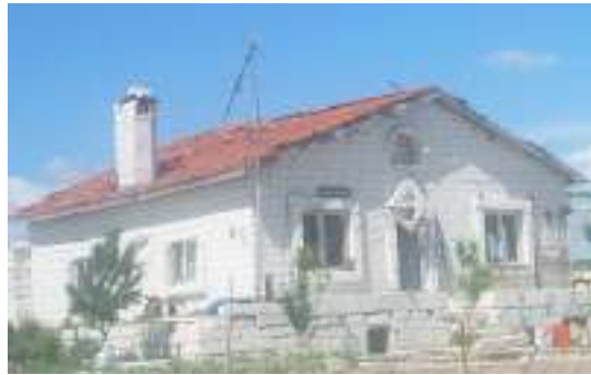
Şekil 5.2. Derbent'de tüften yapılmış bir ev
