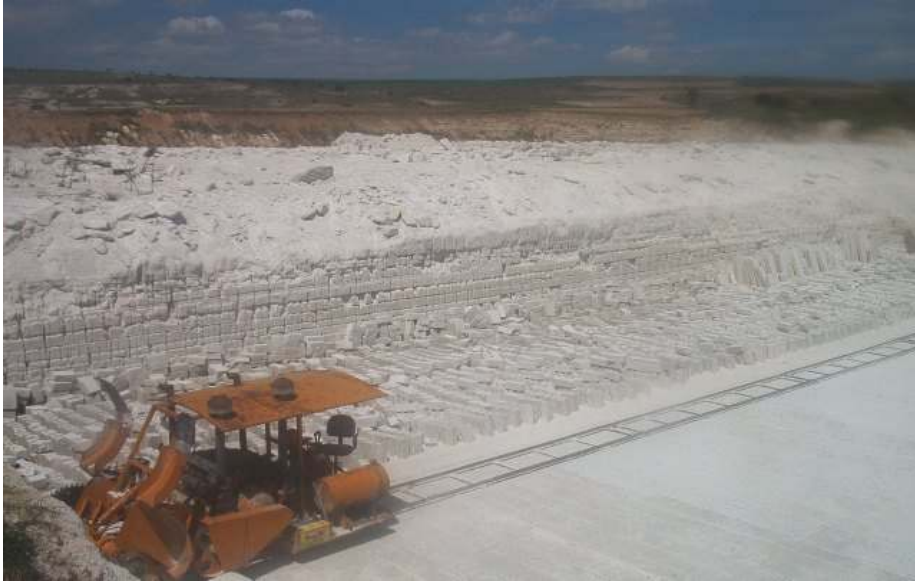
Şekil 7.2 Derbent taş kesme ocağında ray yerleştirme işlemi
