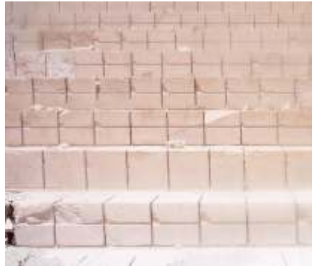
Şekil 4.1 Derbent bölgesine ait pembe tuf blokları
