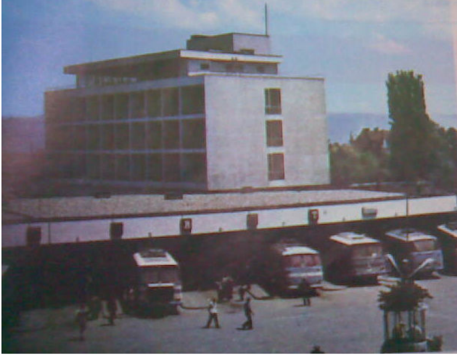
Şekil 3.10. 1963 – 1994 Yılları Arası Otobüs Terminali (www.eskisehir-bld.gov.tr'den) Otobüs terminal binası, Emek Otelle birlikte düşünülmüş bir yapıdır. Fotoğrafta, önde otobüslerin yolcu indirme-bindirmelerini yaptıkları peronlar, arkada ise Emek Otel görülmektedir.
