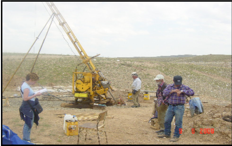
Şekil 6.7. Sahada yapılan sondaj
