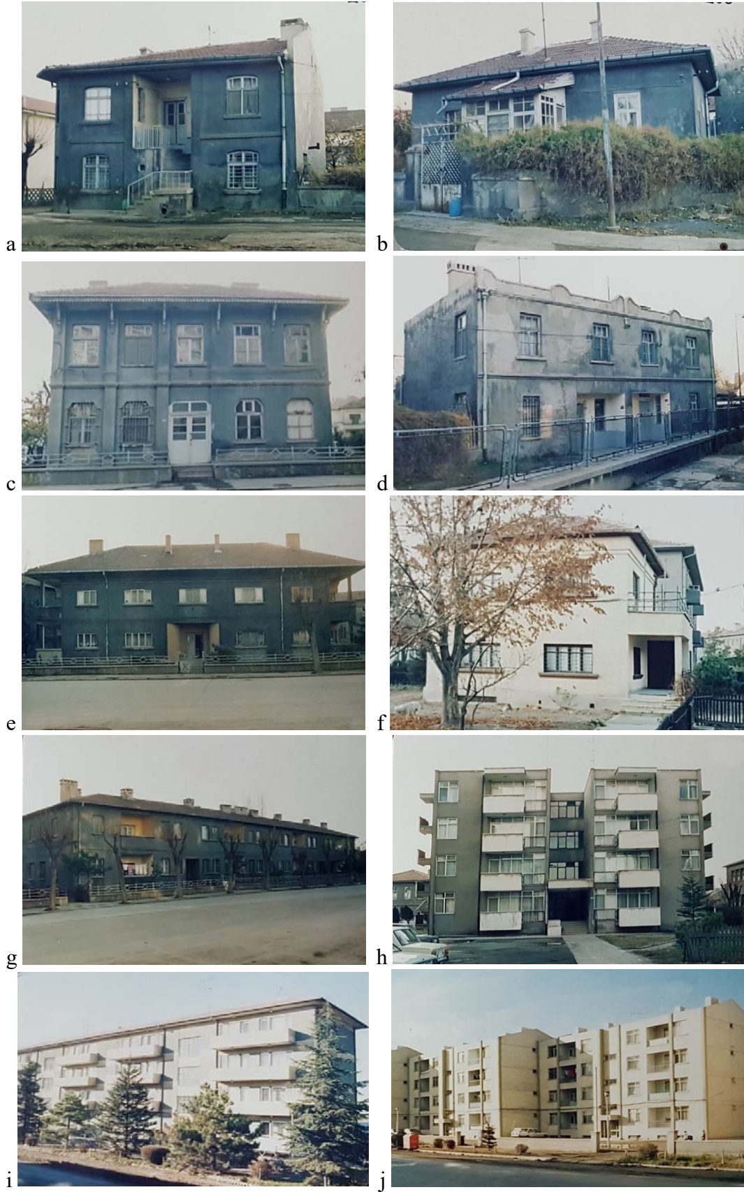
Şekil 4. 17. Yerleşkenin sınırlarını tanımlayan farklı dönemlerde inşa edilmiş lojman tipleri (a, b, c, d, e, f, g, h, i, j) (TÜLOMSAŞ ARŞİVİ, 2019).
