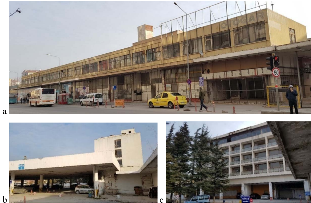
Şekil 5. 18. Emek Otel ve Eski Otogar: a) Yunus Emre Caddesi'nden Eski Otogar'ın bugünkü görünümü, b-c) Emek Otel'in bugünkü durumu (Özel Arşiv).
