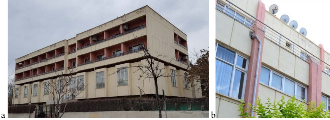
Şekil 5. 10. Cephe hareketleri, fuga ve kolon uçları: a) Ön cephe, b) Arka cephe (Özel çekim, 2019).
