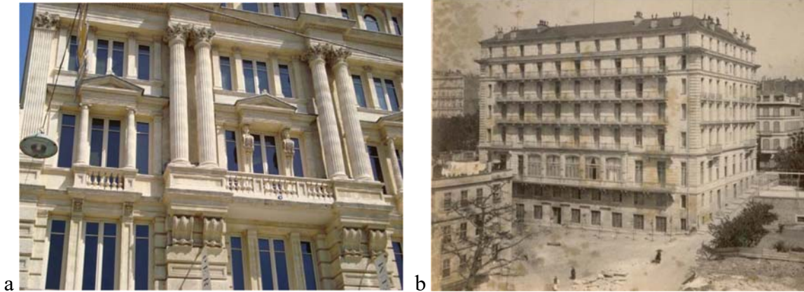
Şekil 4. 23. 19. yüzyıl İstanbul - Pera otellerinden örnekler: a) Bristol Oteli (Çilli, 2009), b) Pera Palas (Çilli, 2009).
