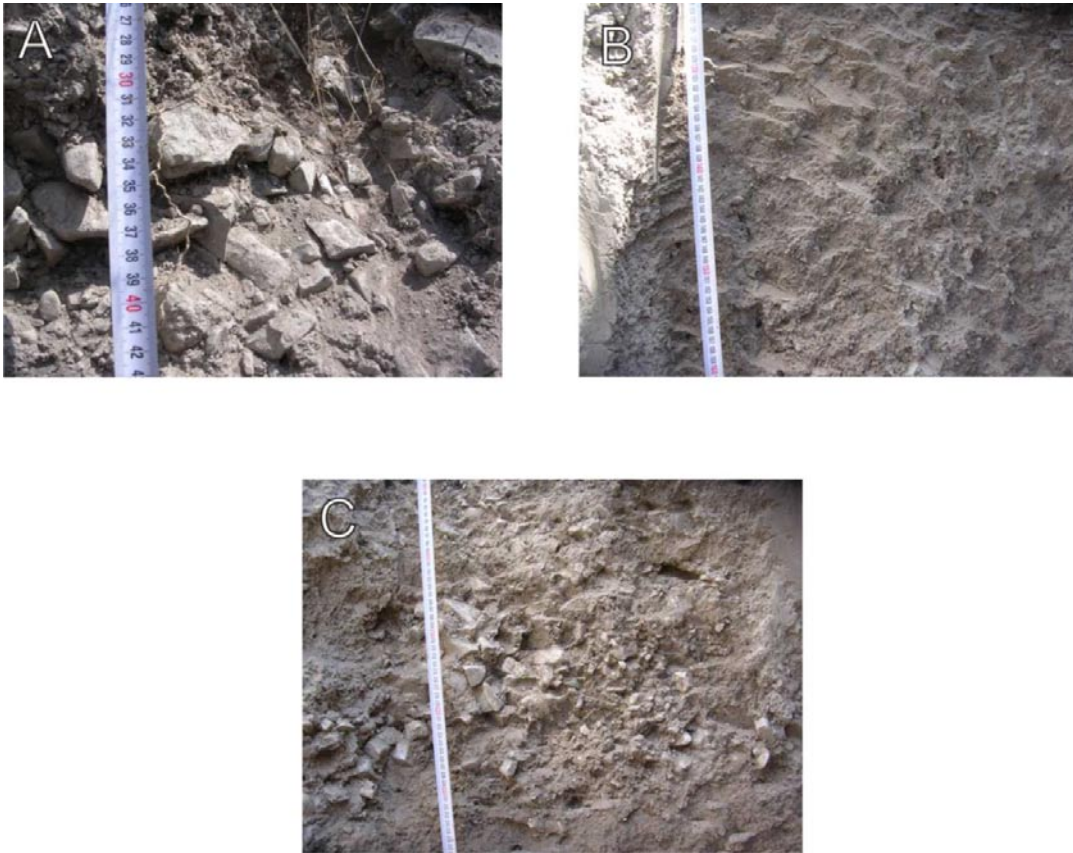
Şekil 3.7.1. CH-2 hendek duvarından görüntüler (A,B ve C).
