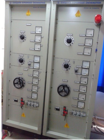
Şekil 5.4 TVA sistemine özel güç kaynağı
