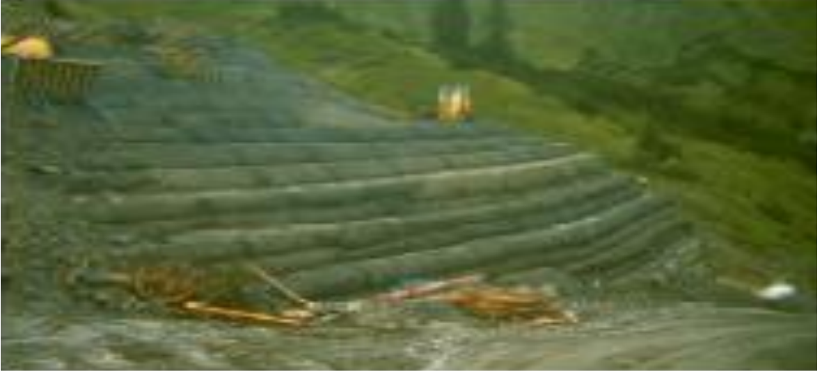
Şekil 2.44. Şevin geogrid ile stabil hale getirilmesi.
