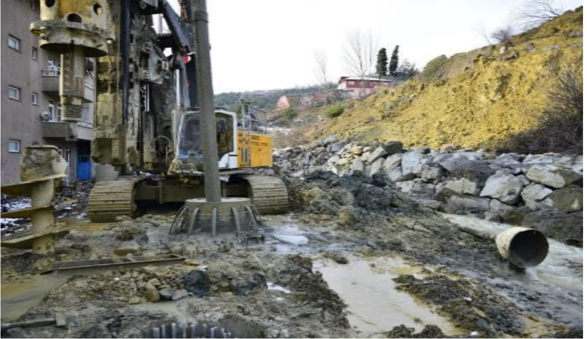
Şekil 2.11. Devrek Heyelanının hareketini durdurmak için yapılan çalışmalar.
