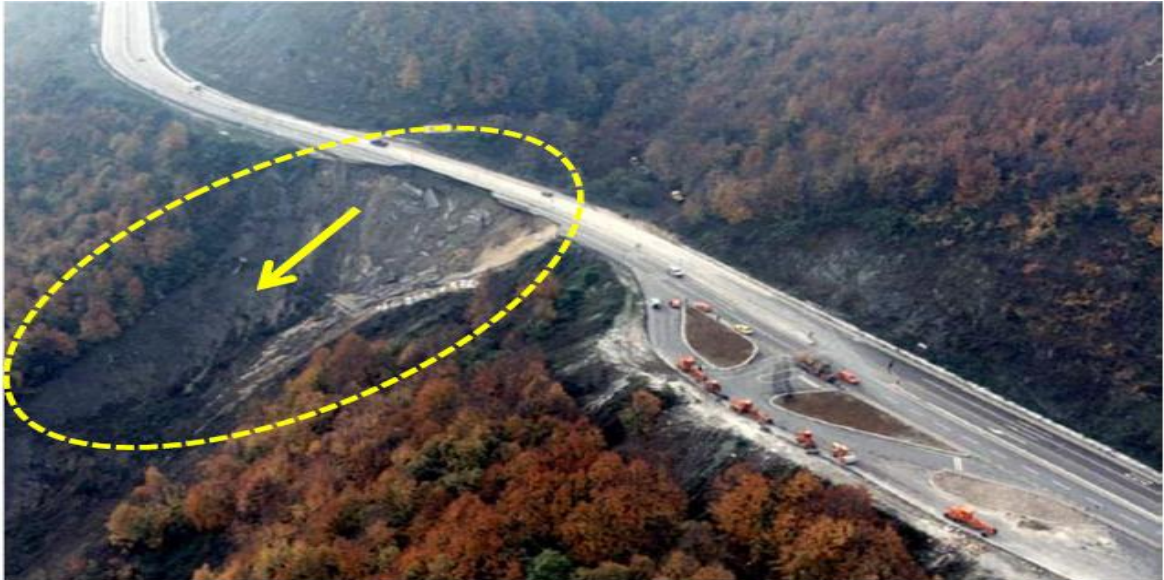
Şekil 2.7. Heyelan nedeniyle etkilenen ulaşım (Düzce depremi sonrası Bakacak Mevkii, Bolu Dağı yolu), (Ankara- İstanbul Yolu).
