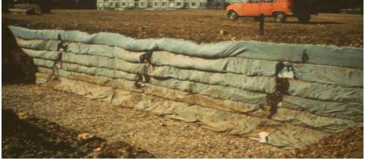
Şekil 2.37. Geotekstil kullanılarak güçlendirilen şev (Roven-Fransa, 1971).
