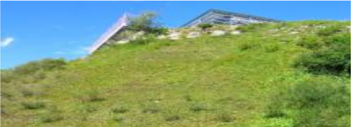
Şekil 2.43. 20 yıl geçmesine rağmen geogrid ile onarılan şevin hala duraylı durumda olması.
