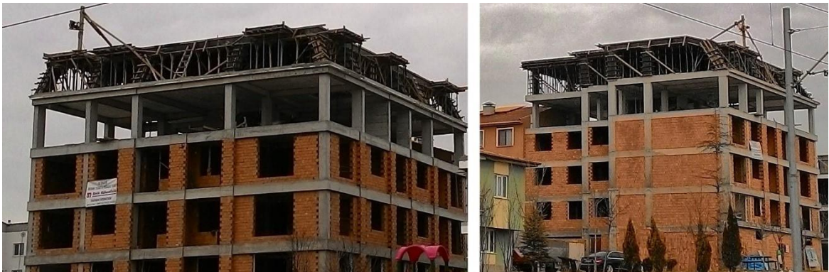
Şekil 1.2. Betonarme yapılarda betonarme Mansard tipi çatılar
