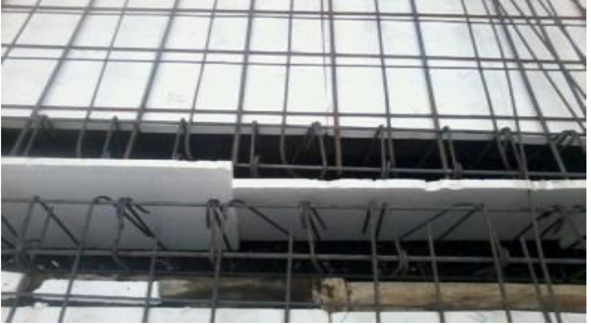
Şekil 5.31. Çekmenin bulunacağı kata dilatasyon konulması
