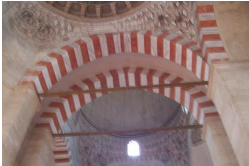
Şekil 6.18: Kemer elemanda açıklık gergisi.
