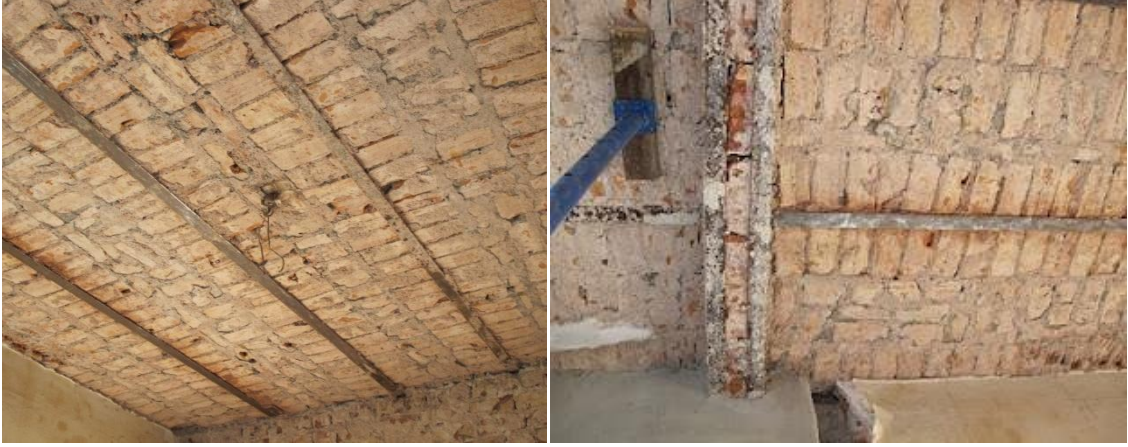
Şekil 8.7: Kilit ve geçme taş yöntemleriyle yapılmış bir volta döşeme örneği
