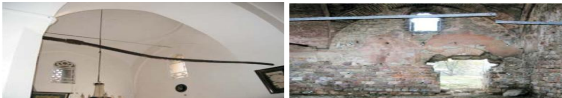
Şekil 9.12: Demir gergide hasar biçimleri
