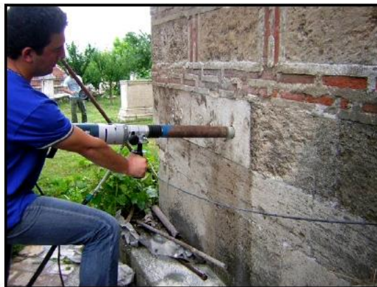
Şekil 9.24: Yapıdan numune alınması
