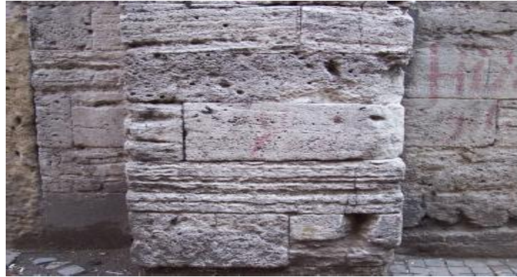
Şekil 6.17: Sıfır derz taş duvar.
