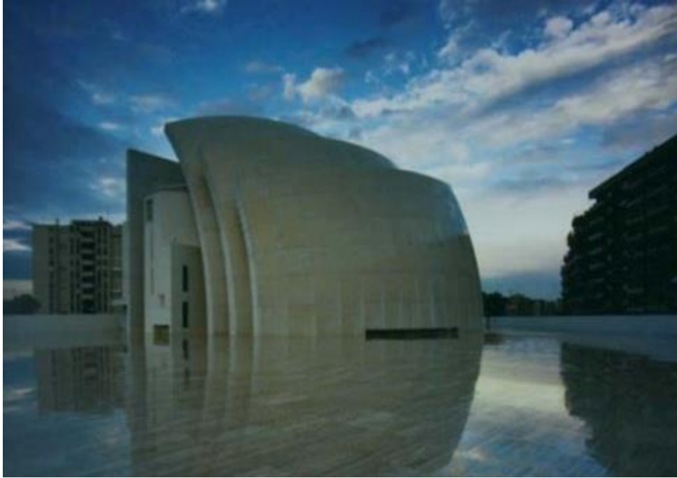
Şekil 3.10. Kendi kendini temizleyen beton ile üretilen yapı örneği, Jubilee Kilisesi (Karagüler, 2014).
