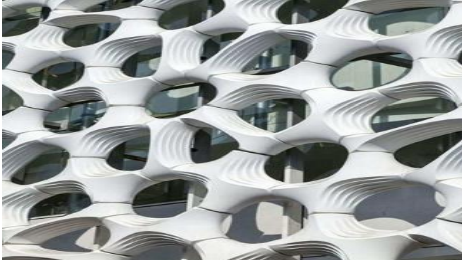
Şekil 3.11. Manuel Gea Gonzalez Hastanesi'nin fotokatalitik beton içeren cephesi (Orhon, 2014).
