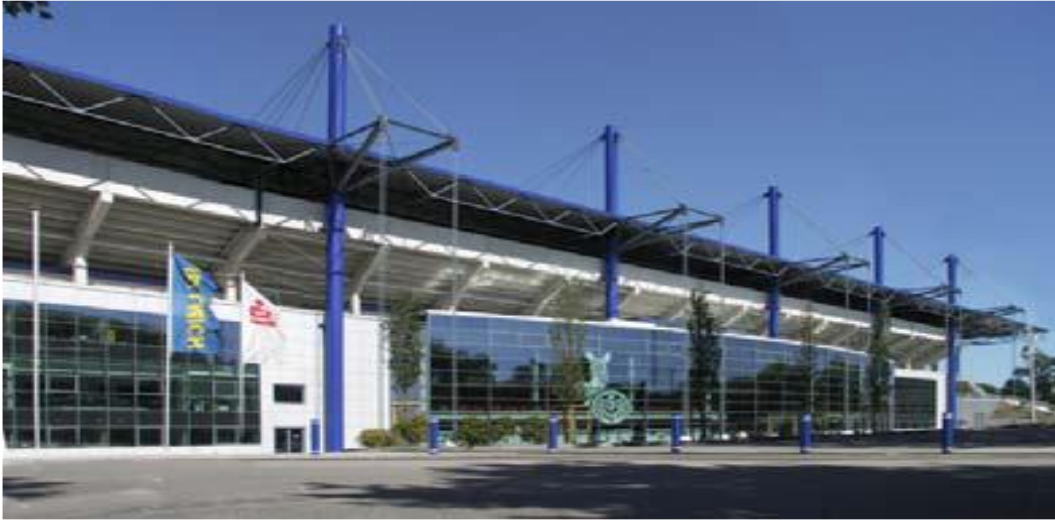
Şekil 3.13. MSV Arena Futbol Stadyumu Ön Cephe Görünümü (Gür, 2010).
