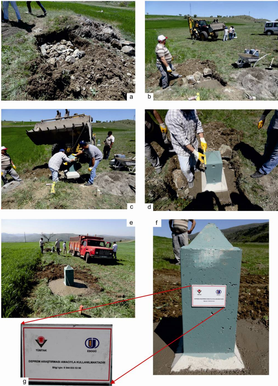
Şekil 5.22.a.b.c.d.e.f.g. Deformasyon takibi amacıyla fay zonu üzerine yerleştirilen direklerin kurulum aşamaları.
