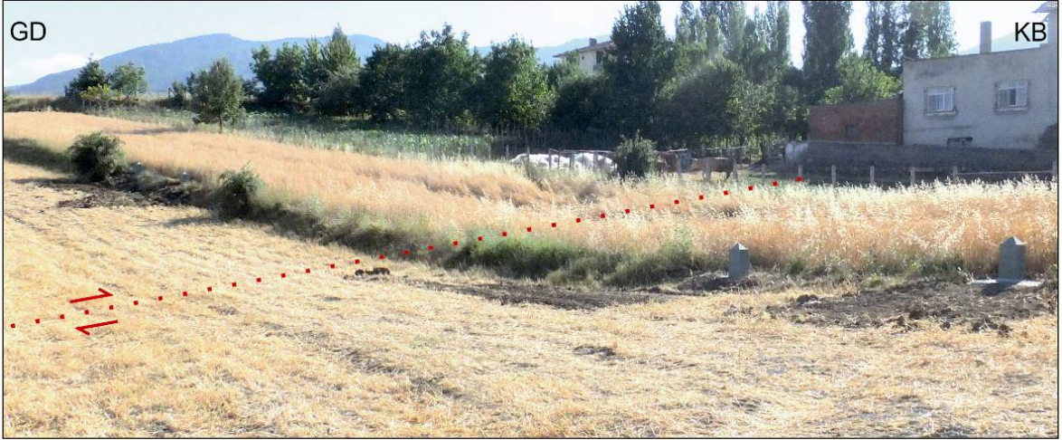
Şekil 5.25. Destek istasyonu. 3. lokasyona beton direklerin inşasından sonra alanın görüntüsü (kırmızı kesikli çizgi fay uzanımını göstermektedir).
