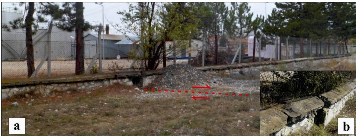
Şekil 2.1. 1944 depremi yüzey kırığı üzerinde yer alan İsmetpaşa asfalt istasyonu duvarı a . Duvarın genel görünümü (fay uzanımı kırmızı kesikli çizgi ile görülmektedir) b . Duvar üzerinde krip nedeniyle oluşmuş ötelenmenin yakından görünümü.
